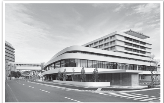
開院した浜松医療センターの新病棟
