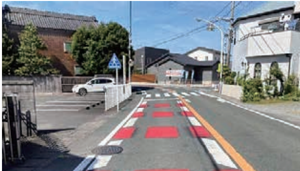
カラー舗装による注意喚起(中央区積志町)
