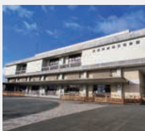
解体工事が予定される旧教育文化会館
