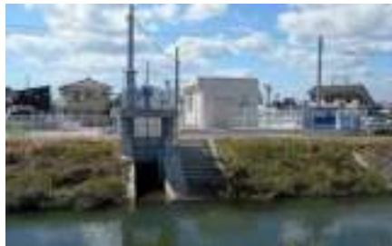
新たに整備した天王雨水ポンプ場 （令和4年度 運用開始）
