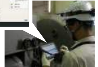
施設情報システムによる設備の状態把握 [中部浄化センター]
