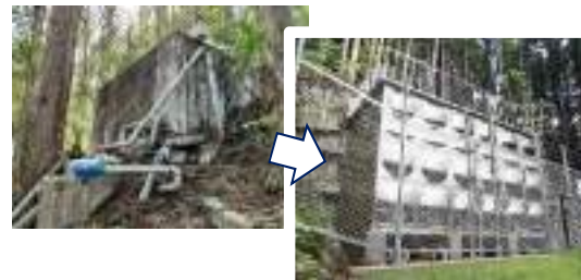
更新により耐震化した中山間地域の配水池（令和5年度）
