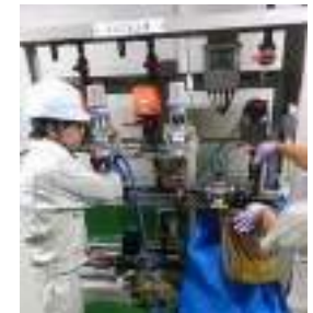
薬品注入機の修繕 [常光浄水場]
