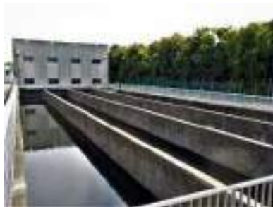
中部浄化センターの運用開始当時から稼働している塩素混和池
