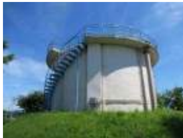
大原浄水場の運用開始当時から稼働している蓄水井
