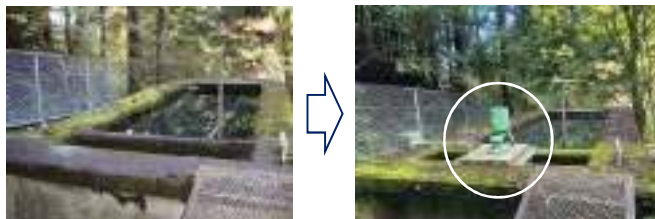
急速攪拌機の設置により浄水施設の機能強化を行った 中山間地域の浄水場（令和3年度）
