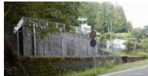
濁水対策のため、急速攪拌機の導入による 浄水施設の機能強化を検討している中山間地域の配水池
