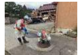
令和6年能登半島地震における応援活動 <下水道：復旧活動> [石川県珠洲市]
