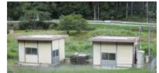
渇水対策のため、水源施設の整備や水融通などを 検討している中山間地域の浄水場
