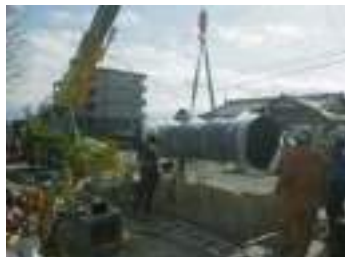
耐震管への布設替えによる基幹管路の耐震化工事
