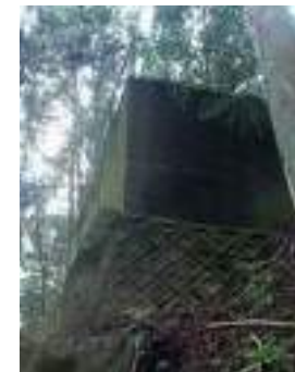
耐震化予定の中山間地域の配水池
