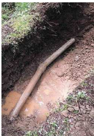
飲料水供給施設の管路修繕(着手前)
