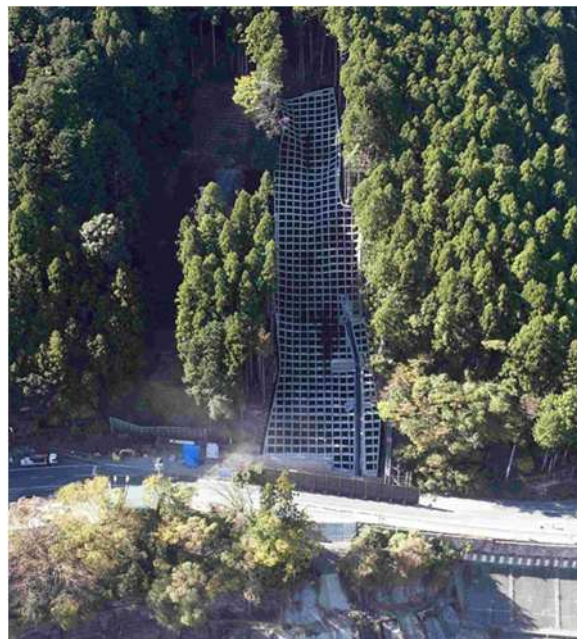
国道 152 号災害復旧工事(完成)
