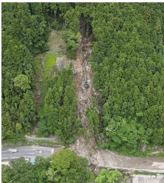
国道 152 号災害復旧工事(着手前)
