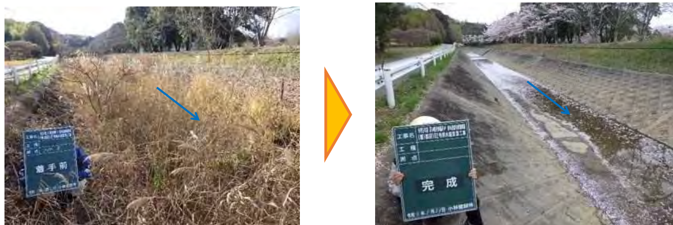
写真 河道の維持管理を行った事例
