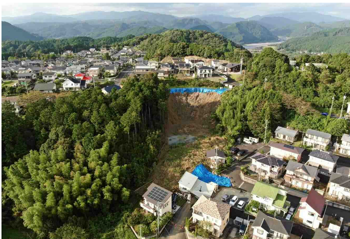
写真 1.1 被災状況 (2022年9月25日撮影)
