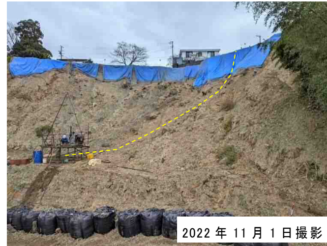
写真-4.3.6 副測線 C-M 付近の斜面状況
