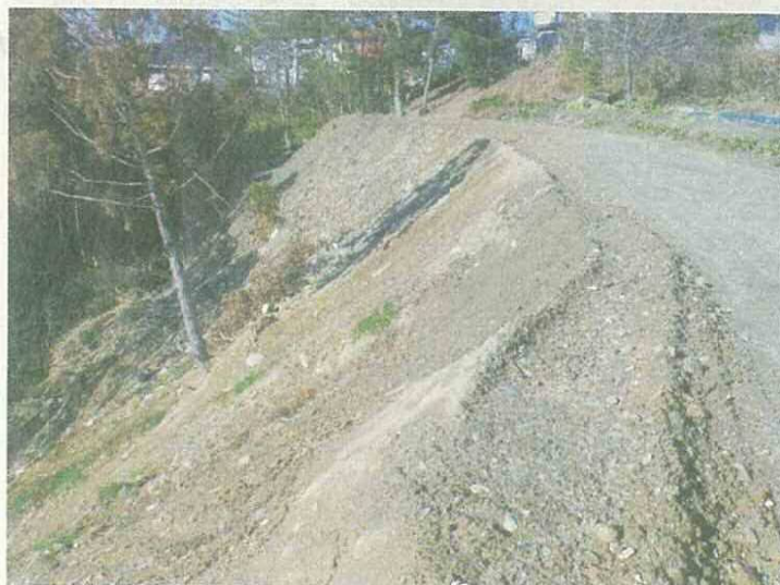
南側斜面の状況
