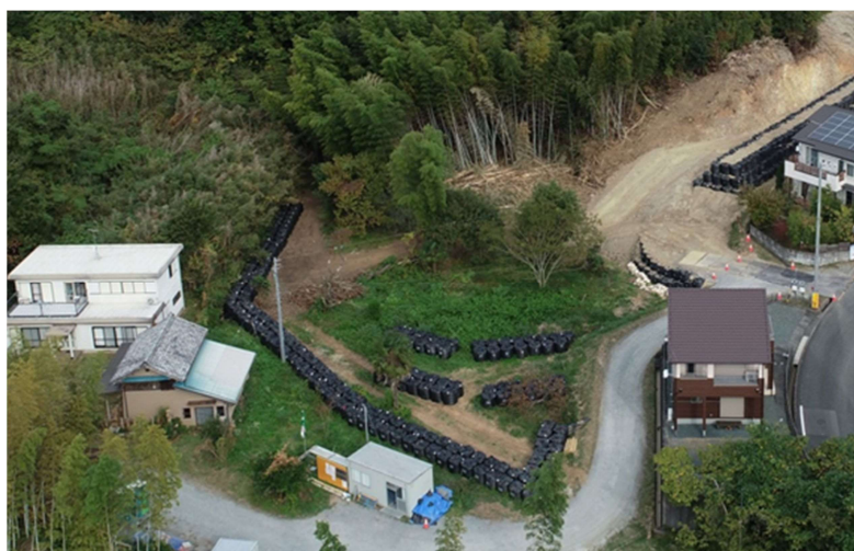
写真-6.2.1 沈砂池（2022年11月7日撮影）
