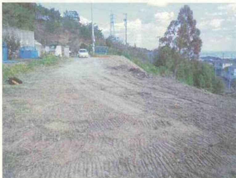
西側から東側を撮影した状況
