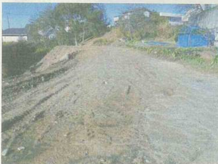
出入り口付近から奥（西側） を撮影した状況
