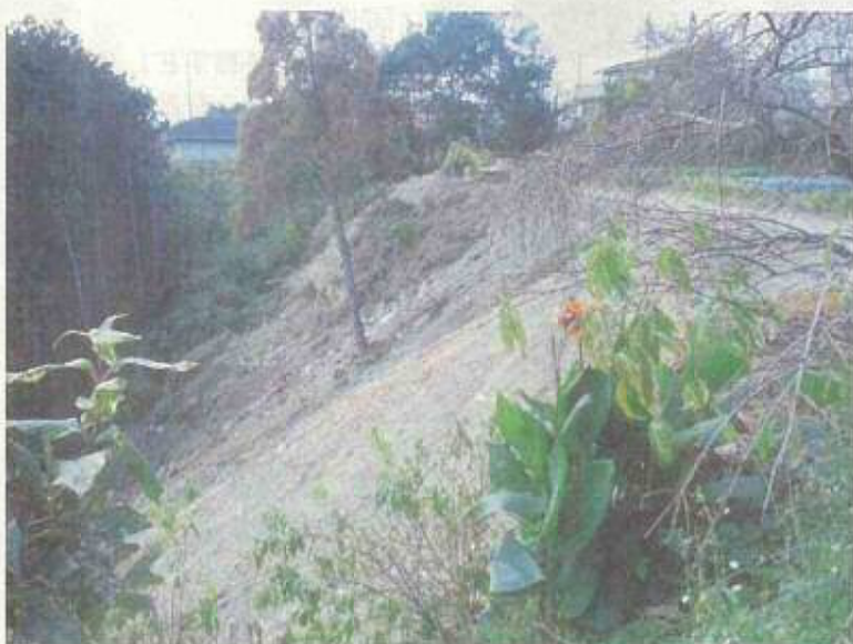
南側の法面の状況
