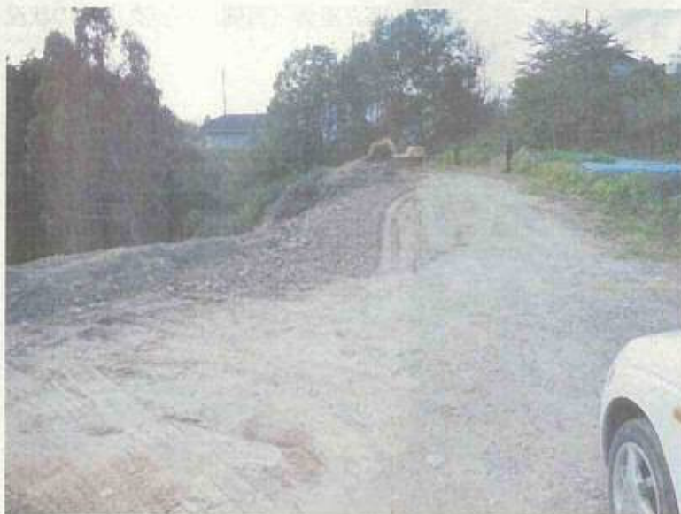
埋立地出入り口付近東側から西側を撮影した状況
