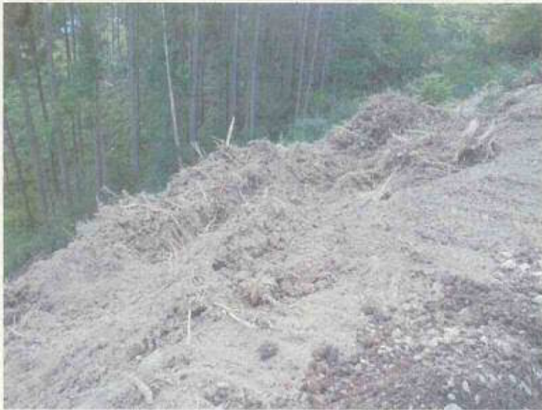
南側法面木の根投棄状況
