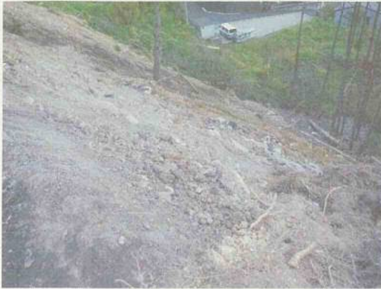
南側法面コンがらの状況
