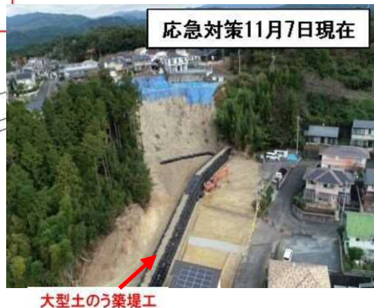
大型土のう築堤工
