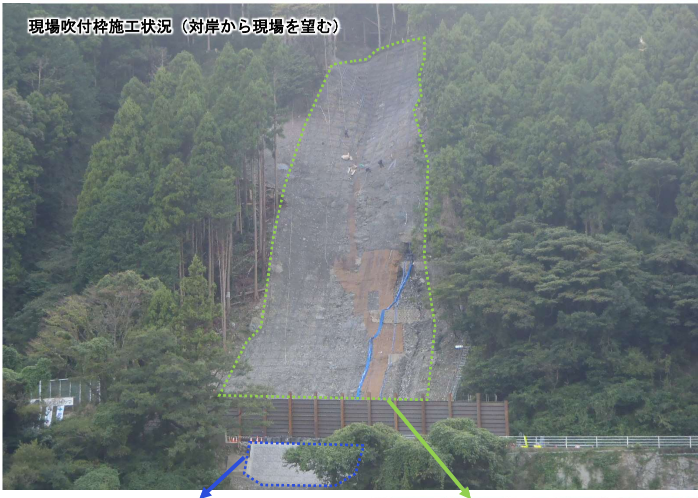
現場吹付砕施工状況 (国道から現場を望む)
