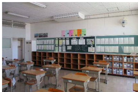
市立小中学校空調設備
