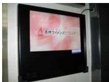
本庁舎 1階エレベーター乗場
