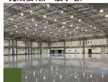
完成後(第一展示場)
