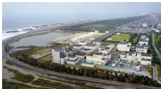
西遠浄化センター 写真提供：旧静岡県下水道公社
