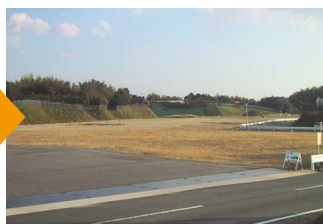
埋め立て終了(平成19年)
