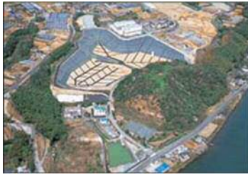
写真① 平和最終処分場
