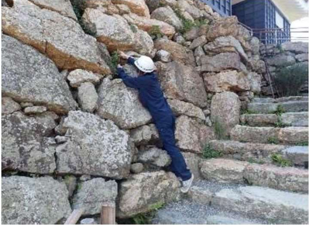
浜松城跡石垣調査状況
