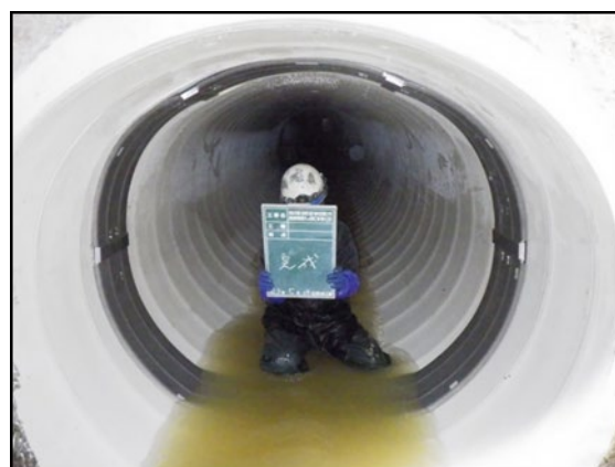
&lt;改築後&gt;管更生を実施した管路
