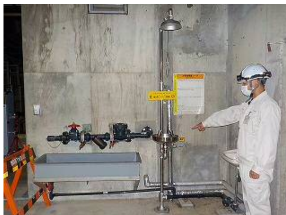
図 8 安全対策後(薬品飛散時緊急シャワー)
