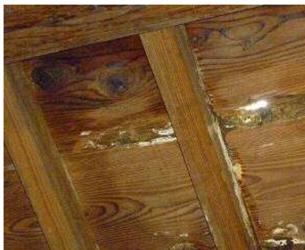
写真4 雨漏り状況
